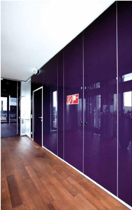
Glaswandverkleidung mit integrierter Technikinstallation
